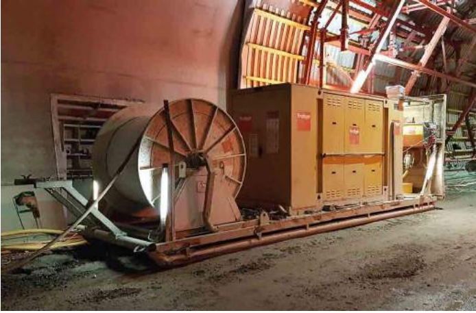
Tünel İnşaatı / Tunnel Construction
