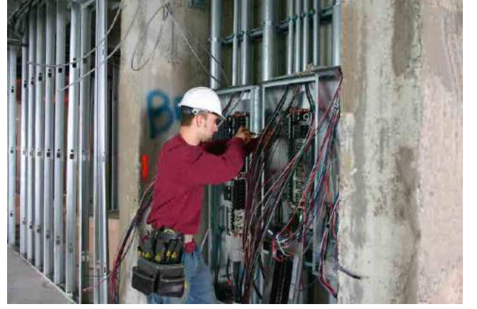
ELEKTRİFİKASYON İŞLERİ ELECTRICAL INSTALLATION WORKS
