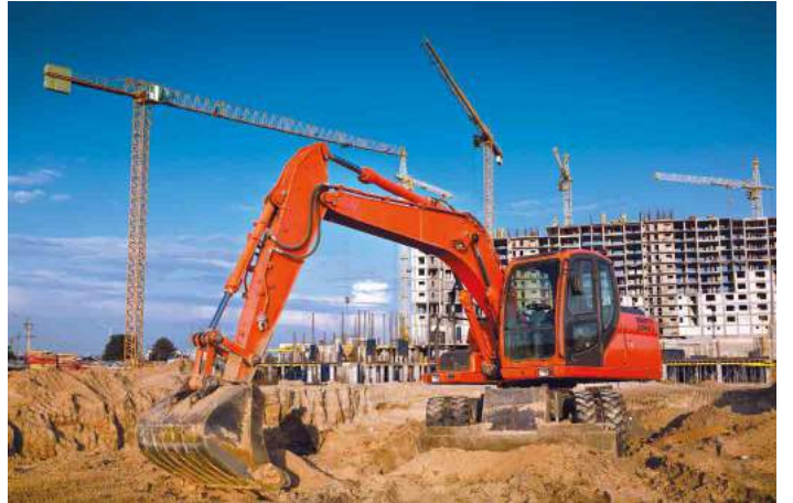
İnşaat Alanları / Construction Site
