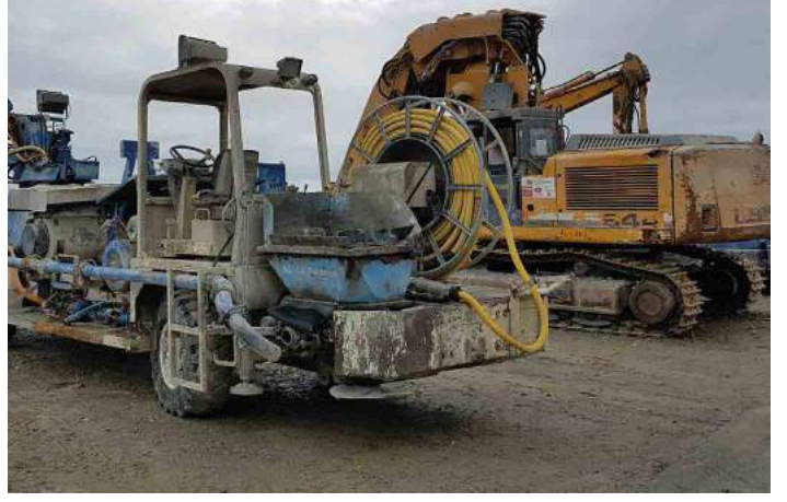
Tünel İnşaatı / Tunnel Construction
