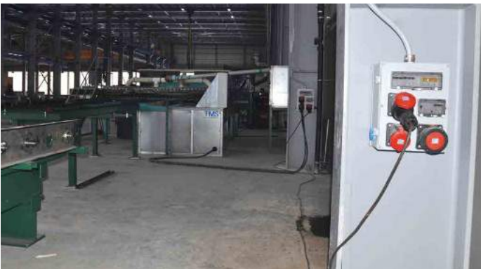
FABRİKA UYGULAMASI - FACTORY / İSTANBUL
